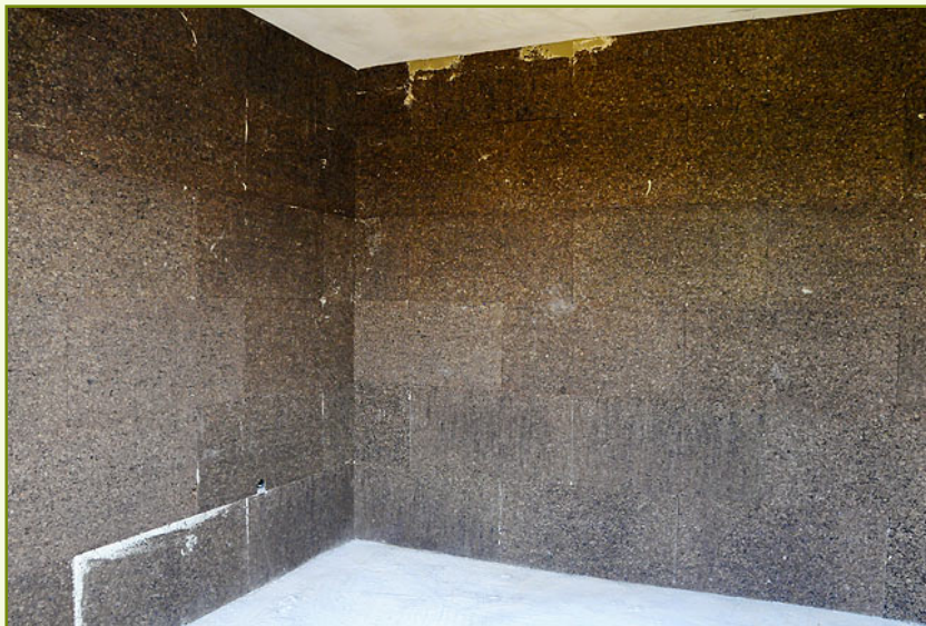
Zidovi pokriveni oblogama industrijske plute u debljini od 2cm.
