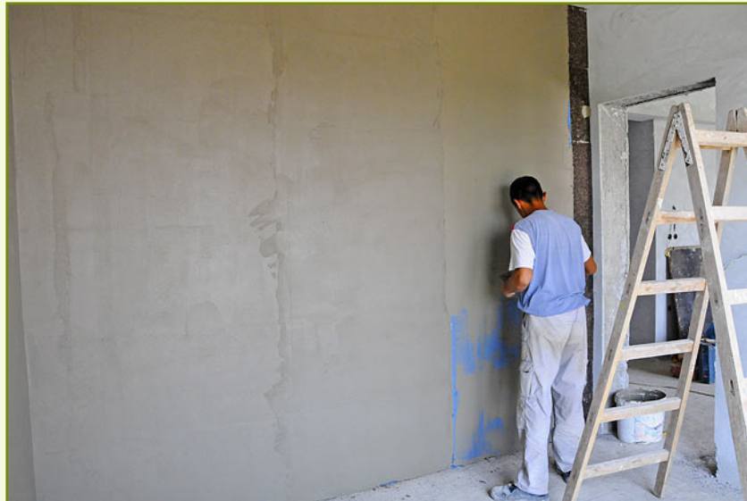
Nanošenje drugog sloja lepka preko armaturne mrežice.
