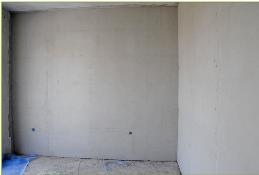
Zidovi završeni sa tri sloja građevinskog lepka.
