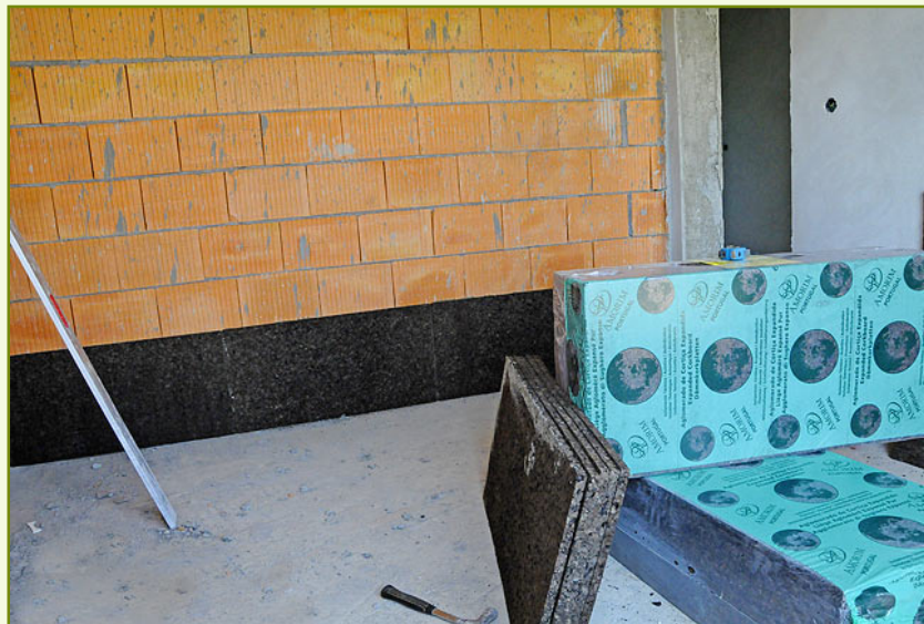
Početak postavljanja Armorim plutanih obloga u Amadeu II.
