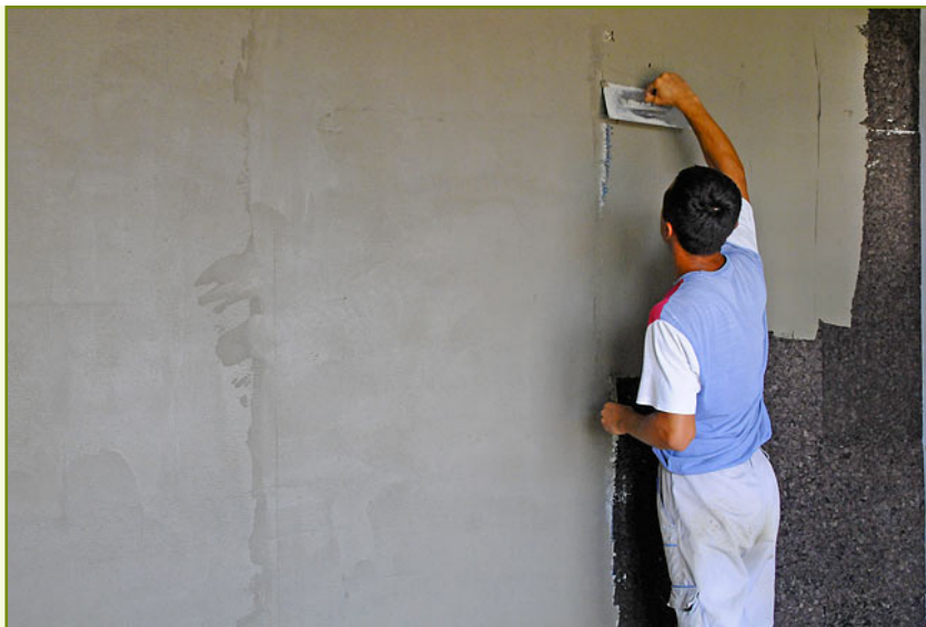
Nanošenje prvog sloja lepka direktno na plutane ploče u širini mrežice. Predhodni pojasevi u širini mrežice, već imaju mrežicu urađenu ispod lepka.
